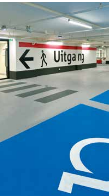
Het nieuwe slijtvaste vloersysteem in parkeergarage P5 Vredenburg bij Hoog Catharijne.
