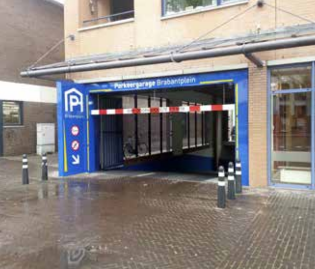
Nieuwe entree parkeergarage Brabantplein
